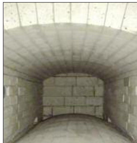
Großes Feuerraumvolumen und gestufte Luftführung
